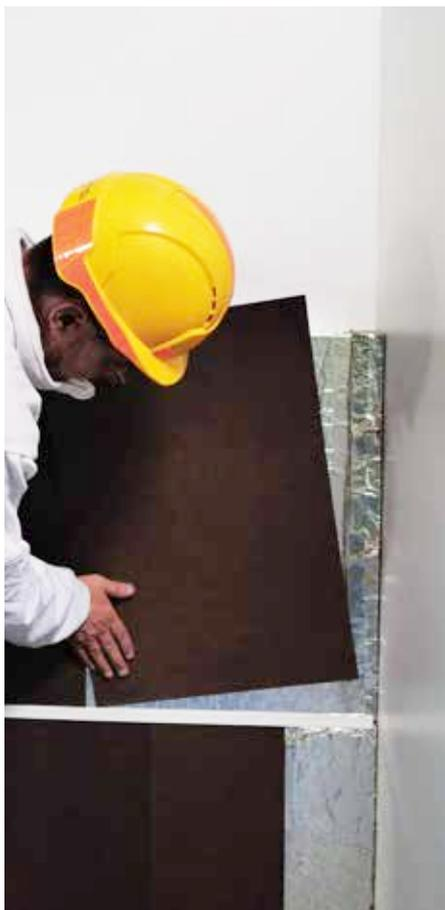
LES PANNEAUX SLIMISOL PAN PROTECT **EMPÊCHENT CLOUS ET FORÊTS BÉTON D'ALLER TROP LOIN !**
